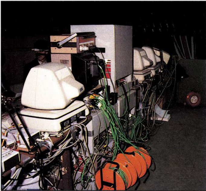
Sehr viele Kabel sind zu verlegen. Auf dem Foto sehen Sie den kleinen Ausschnitt der Anlage auf dem Richterturm.
