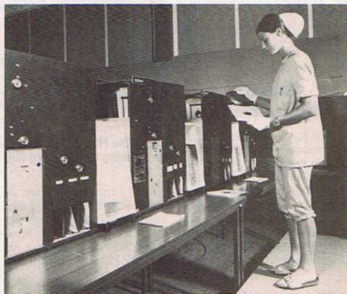
Bild 3. Diskettenherstellung um 1975: Von Hand wurden die Magnetscheiben (»Cookies«) in die Diskettenmäntel verpackt.
